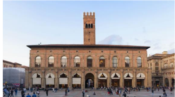
Figure 7; Palazzo del Podestà
